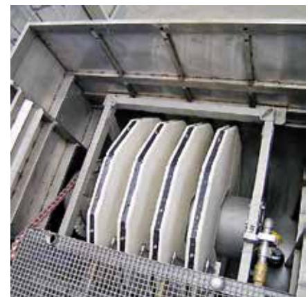
Schema tipico filtro MITA a dischi
